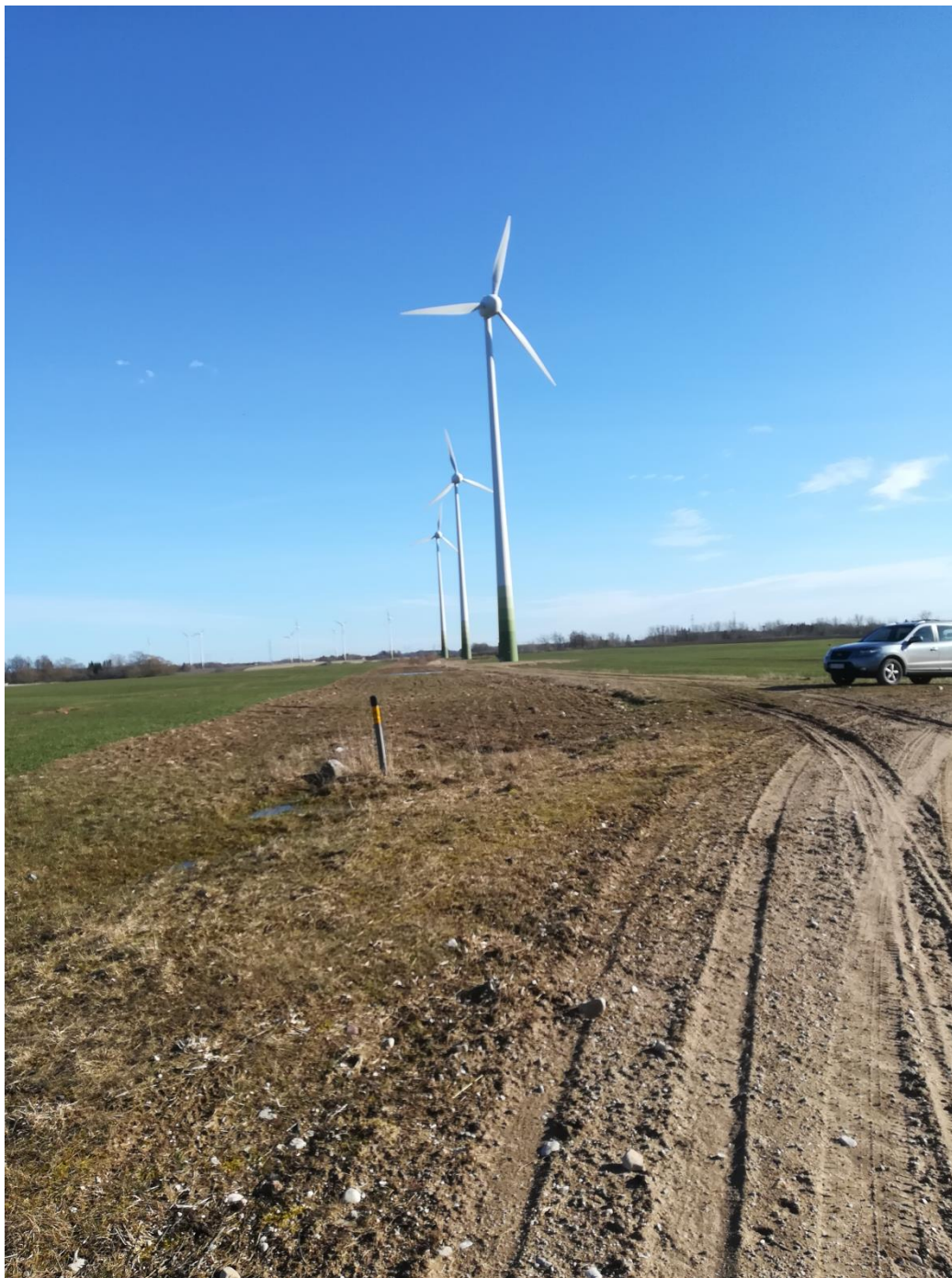
Attēls 3.1. Skats uz Grobiņas VES parka daļu. Attēla vidū redzams pazemes kabeļa marķējums, kura tuvumā tika veikts pirmais magnētiskās plūsmas blīvuma mērījums (10, 53 nT)
